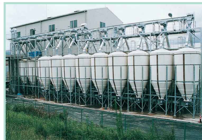
飼料タンク（20基）へ Uトラフスクリーで飼料搬送（エア駆動のシャッターと二股ダンパー付き）
