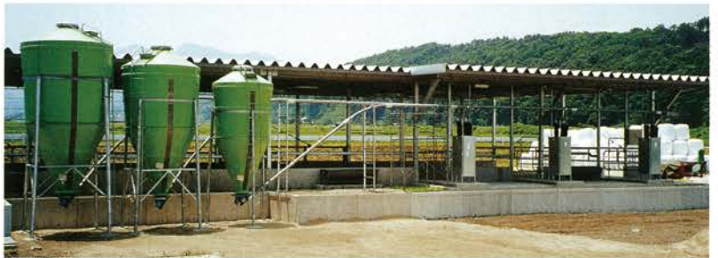
● S-90による搬送ライン
