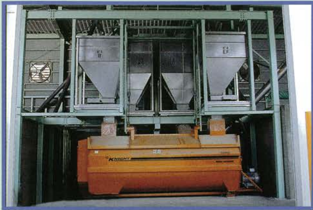
●飼料原料をデジタル計量器に搬入し原料毎に個別にミキサーに投入
