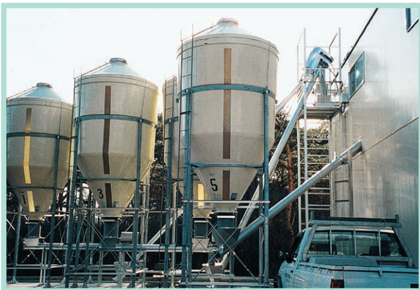
SC-190による飼料搬送 (水平より傾斜スクリューへ中継)
